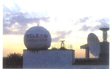
Radaranlage in Neuss
